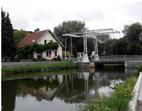
Pont basculant à Courcelles-lès Montbéliard
