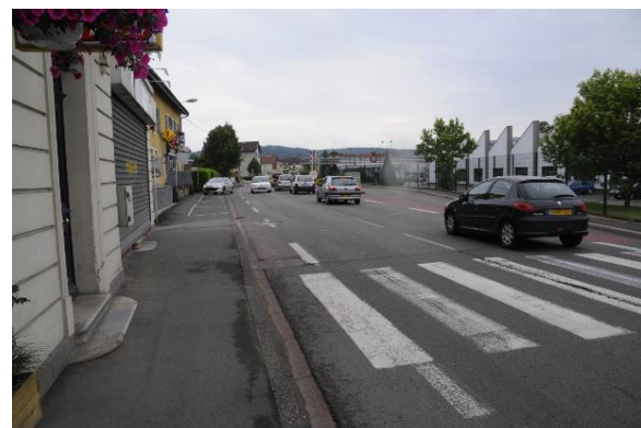
RD 437 à l'entrée de Beaulieu Mandeuire - Vallée du Doubs
