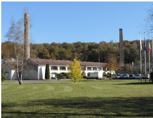
Fesches-le-Châtel – usine Cristel réhabilitée et modernisée
