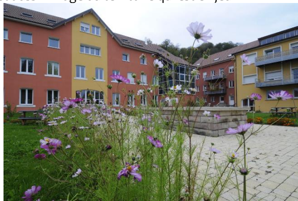
Sainte Suzanne, usine de l'Épée convertie en logements en 2005
