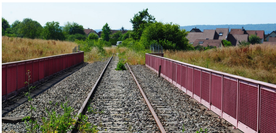
Franchissement ferroviaire désaffecté de l'A 36 au sud de Voujeaucourt, principale opportunité d'un passage à faune aménageable à moindre frais (image : Déforêt T.)
