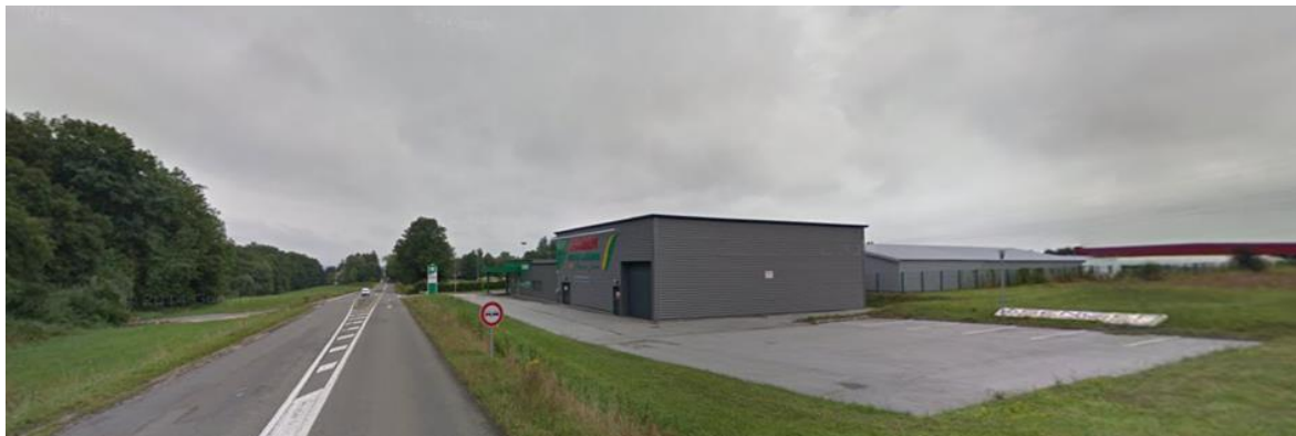
D35 à l'entrée de Seloncourt depuis Bondeval. La volumétrie des bâtiments et les espaces de stationnement de la zone artisanale manquent d'intégration dans le paysage. Source ADU.
