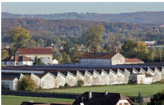
Exincourt – site de la Champagne anciennes filatures Japy à côté du tracé du bus à haut niveau de service
