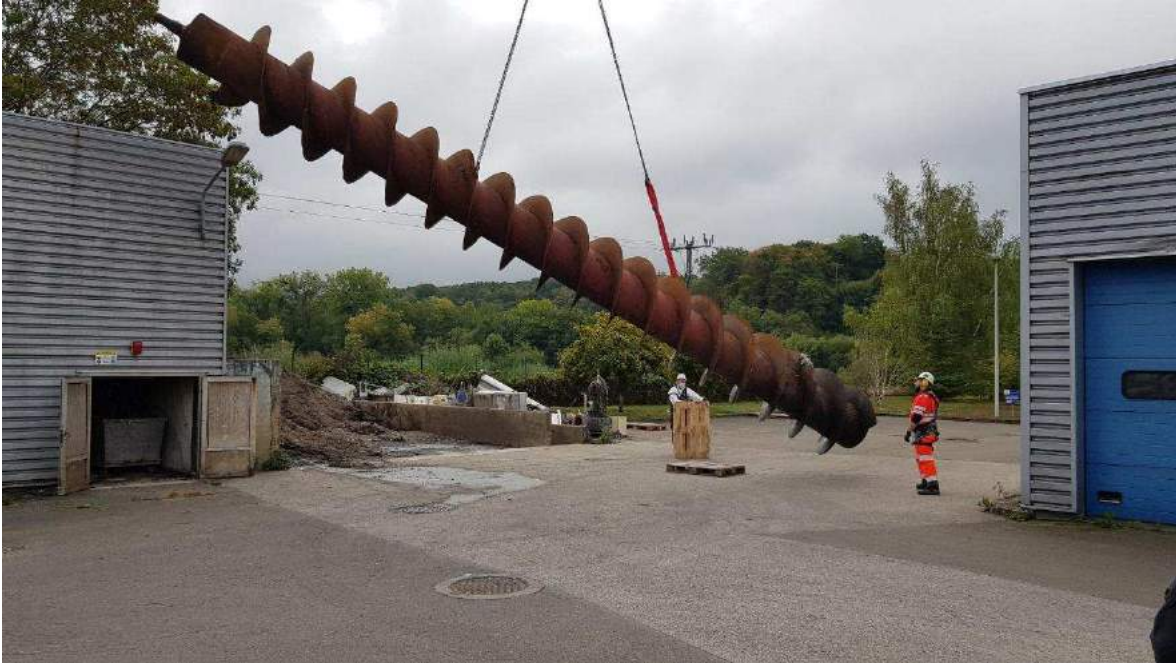
vis en cours de dépose
