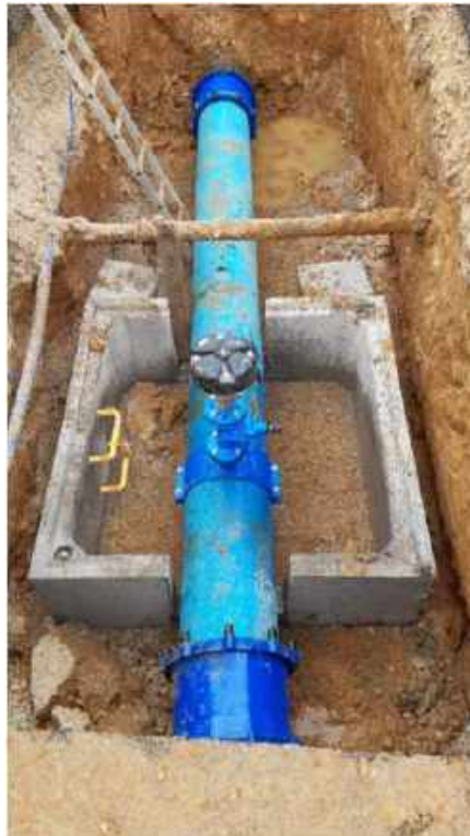
Réparation casse + pose d'une ventouse
