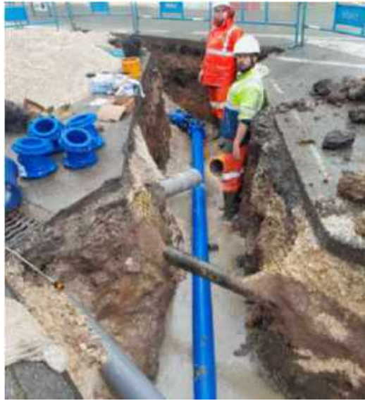
Avenue des Alliés Montbéliard
